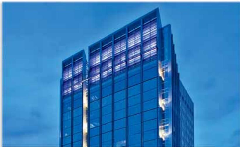
Coroamento iluminado por LEDs com alternância de cores em RGB. Sistema é sincronizado com o do lobby.
